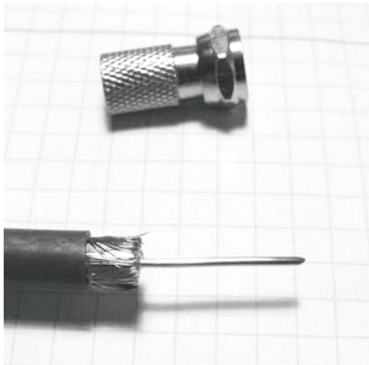
1. Koaxialkabel abisolieren:
