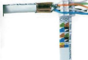
4. Die Kabeladern durch den Kabelmanager führen.
